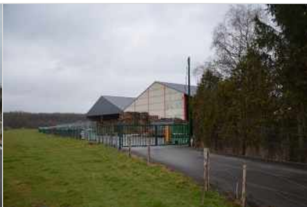
Photo 19 : Hangars de stockage des Ateliers protégés (à l'arrière)
