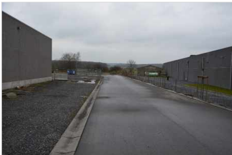
Photo 26 : Voirie privée au Nord-Est du périmètre
