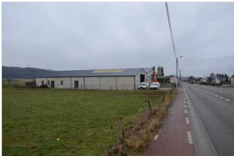
Photo 17 : Bâtiment industriel au Sud de la rue de Rochefort
